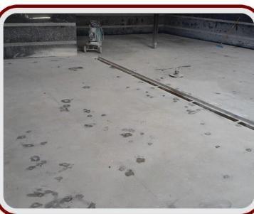
**چسب ترمیم کننده سطح بتن ویژه کفسابی** بر پایه رزین های بوتادی ان رابر بوده و جهت ترمیم و بازسازی کف های بتنی در هنگام کفسابی و میقلی و براق کردن کفپوش های بتنی کاربرد دارد. این محصول باعث ترمیم و پرشدن درزها و ترک ها ضمنن حفظ یکنواختی رنگ سطح بتن می شود. (حداکثر هم رنگ بودن سطح جدید با سطح قدیم را به همراه دارد)
