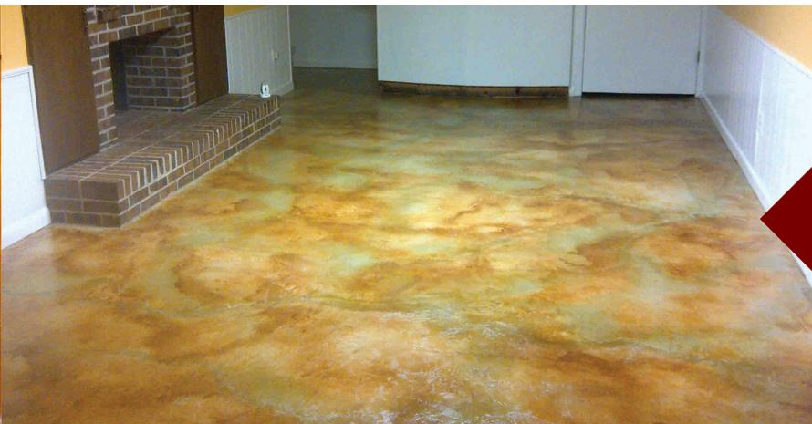
رنگ‌های مخصوص سیمان و بتن مایع اسید استین آب پایه بوده و بر روی سطوح بتنی قدیمی و جدید اعمال می‌شوند. این رنگ‌ها حلال‌های نفتی نداشته و غیرقابل اشتعال می‌باشند. این رنگ‌ها دارای قدرت نفوذپذیری و جزء بافت بتن شدن و مقاومت UV بالا می‌باشند.
