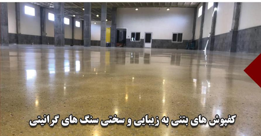
در فرآیند گلیزینگ کفپوش های بتنی با انجام عملیات کف سابی شیرابه سطح بتن حذف شده و سنگدانه ها نمایان می شوند. و در ادامه با اضافه کردن سیلرها و سخت کننده های لیتیومی بر روی سطح این مواد داخل بتن نفوذ می کنند. و باعث افزایش تراکم و سختی، نفوذناپذیری و برآقیت کفپوش های بتنی می شوند.
