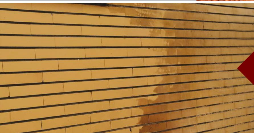
محلول شوره زدا برای از بین بردن انواع شوره‌های سولفاتی و کربناتی بر روی نماهای ساختمانی به ویژه سطوح آجری استفاده می‌شود.
