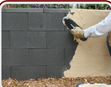
**بتنه ترمیمی دو جزئی** دارای دو جزء پودر (در رنگ های سفید و طوسی) و جزء رزینی مایع به رنگ شیری می باشد. بتنه ترمیمی دو جزئی جهت ترمیم بتن های قدیمی، ستون ها و پایه های بتنی و پرنمودن و ترمیم هر نوع سطح بتنی مناسب می باشد. این محصول دارای مقاومت فشاری و کششی مناسبی بوده و به راحتی بر روی تمام سطوح بتنی اعم از داخلی و خارجی ساختمان و سازه ها قابل اجرا می باشد.
